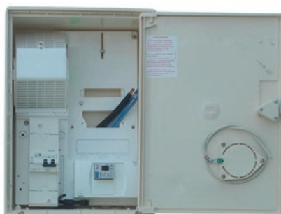
COFFRET DE CHANTIER
